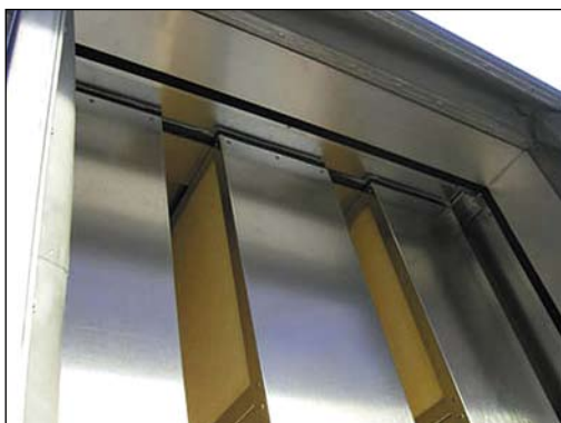
Рис. 3.32а. Пластинчатые шумоглушители
